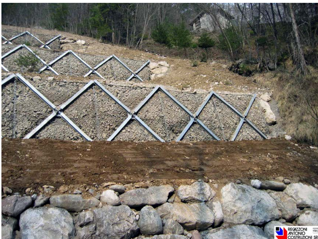
Opere di consolidamento pendio – Valtorta (BG)
