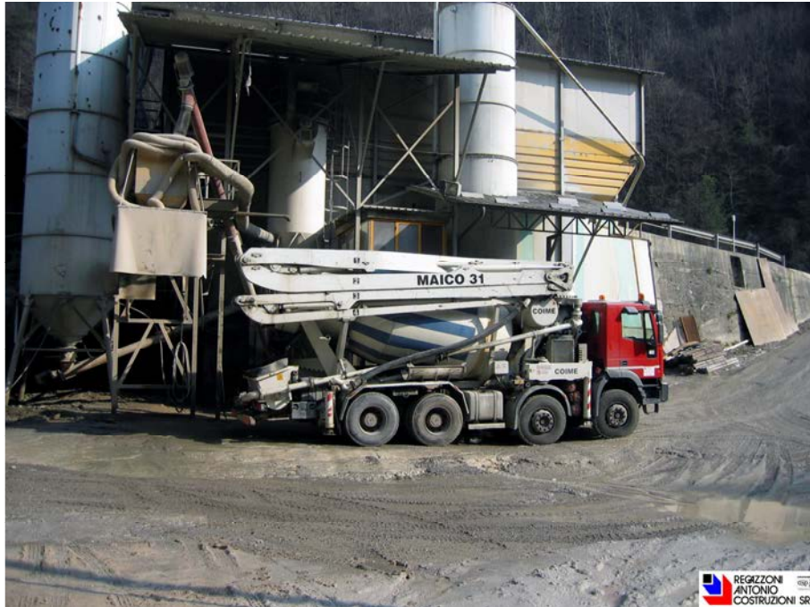
Impianto di produzione calcestruzzo
