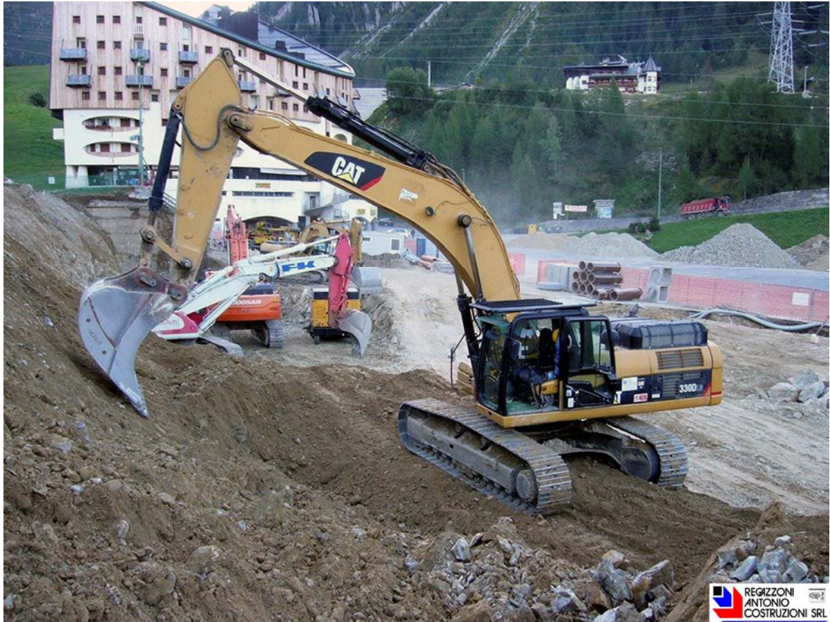
Scavo per realizzazione complesso residenziale "The Belmont"- Foppolo (BG)
