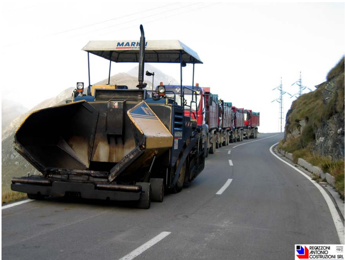
Asfaltatura Passo San Marco (Mezzoldo – BG)
