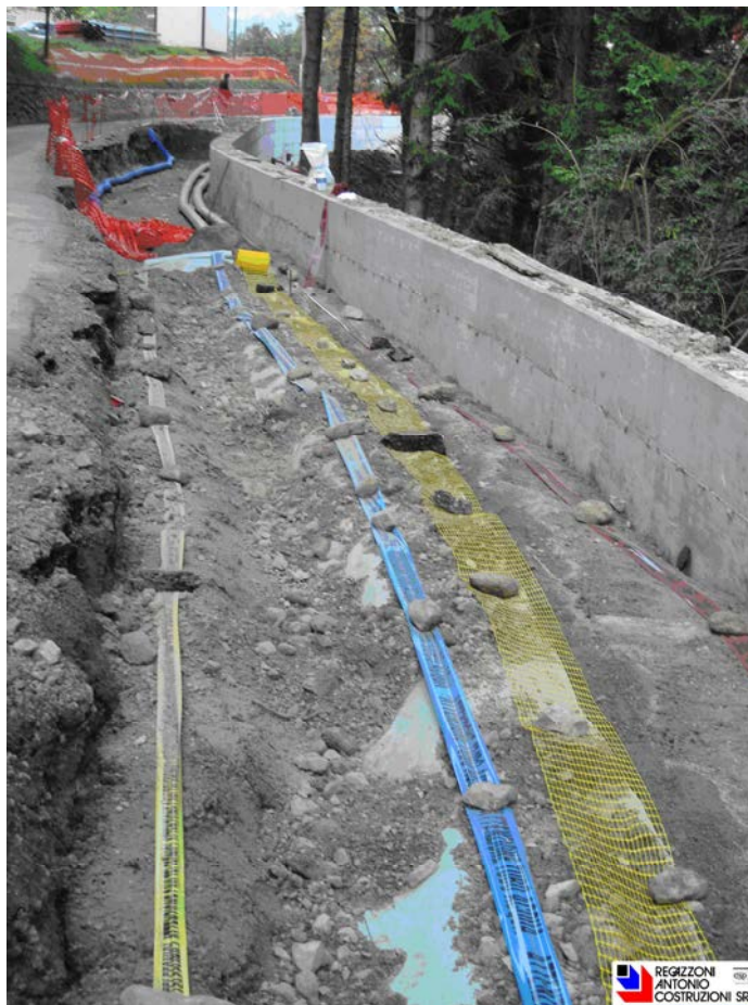
Realizzazione sottoservizi – San Pellegrino Terme (BG)
