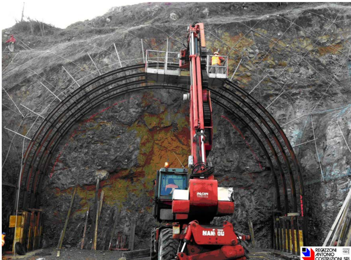
Realizzazione imbocco artificiale galleria - Zogno (BG)
