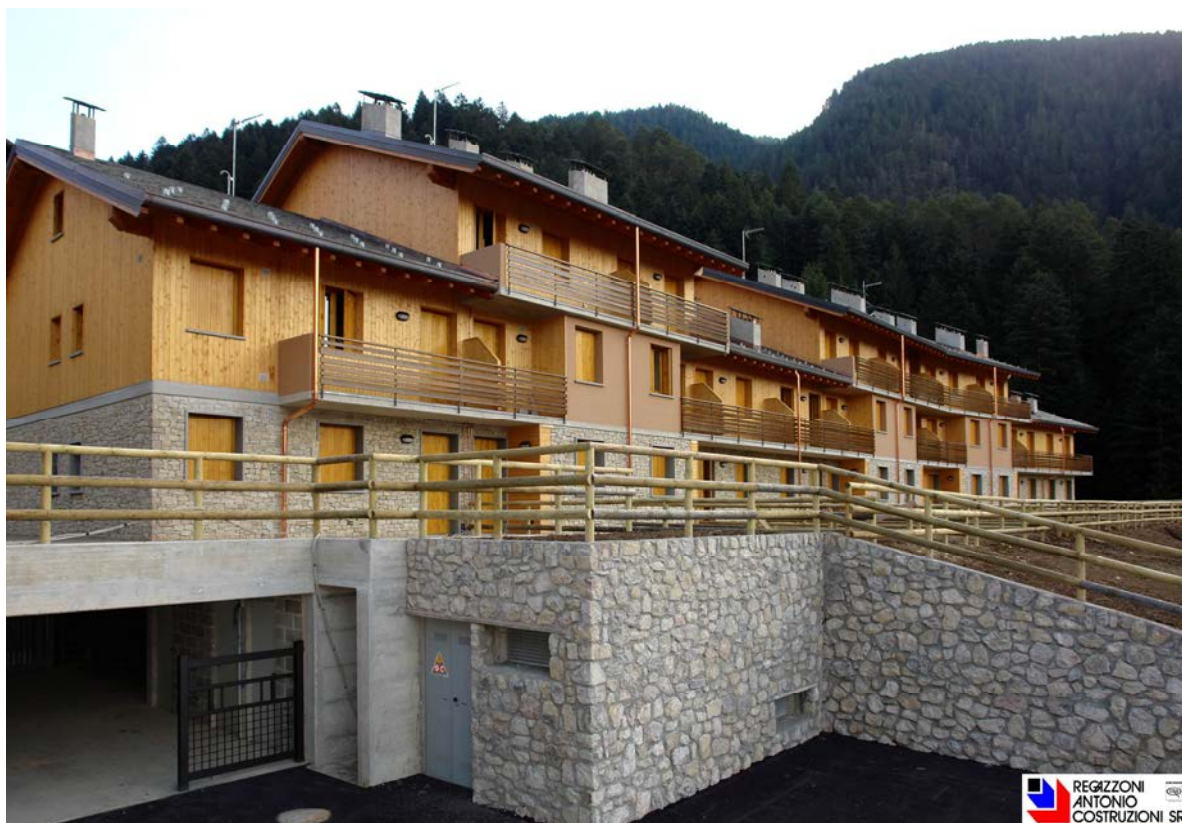
Complesso residenziale "Toracchio" - Piazzatorre (BG)
