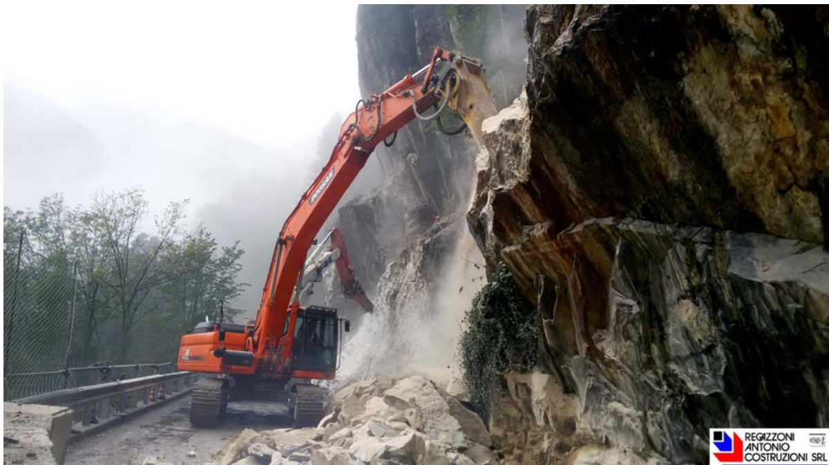
Demolizione facciata rocciosa per allargamento strada provinciale – Branzi (BG)
